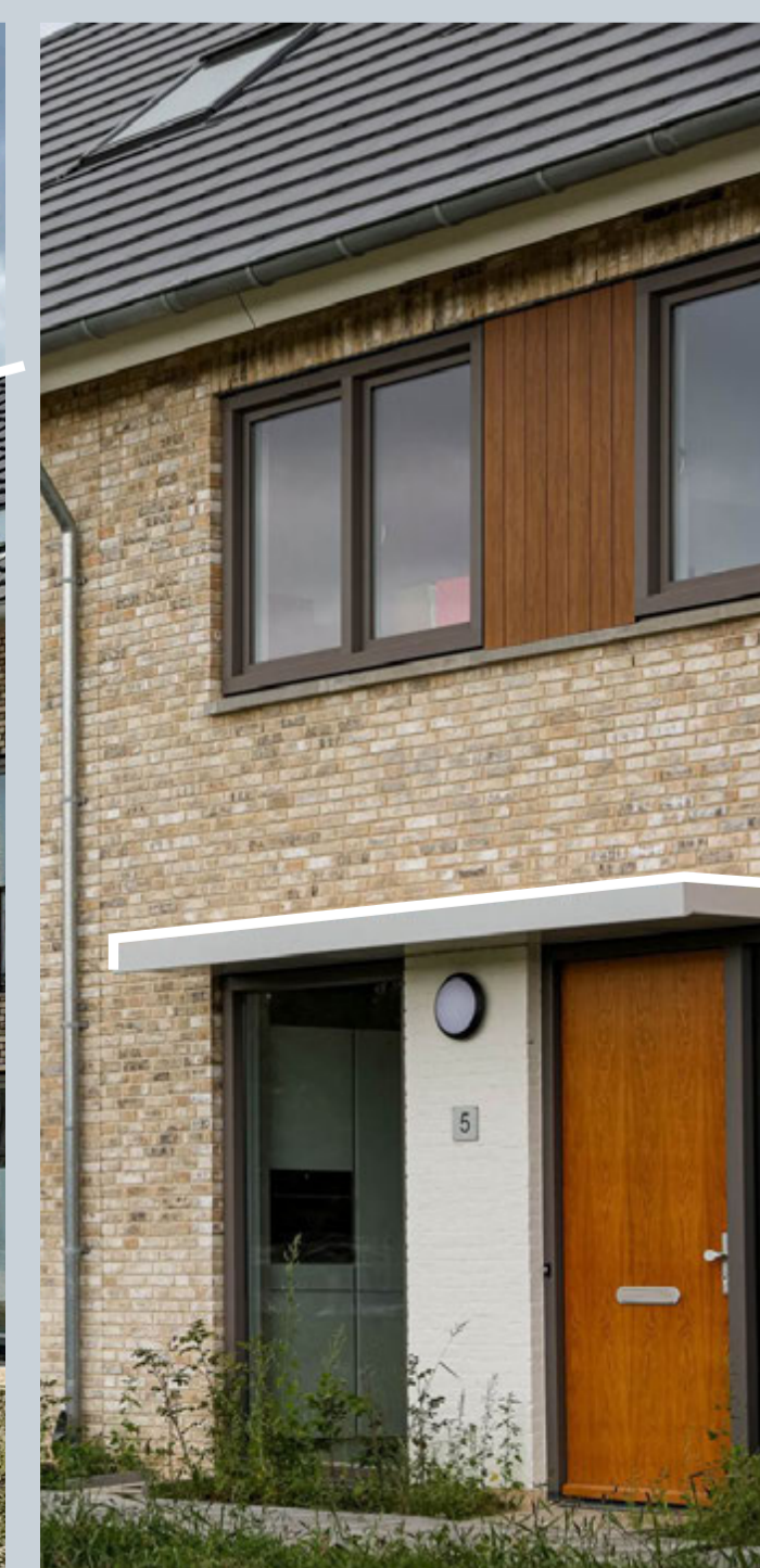
Beschut thuis komen overkapt voordeur aan de dorpsstraat met een haag
