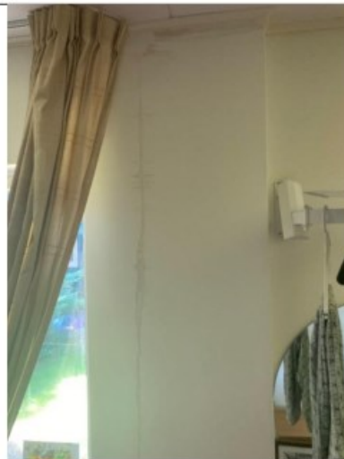
Lekkages vanuit de kinderslaapkamer op de bovenverdieping.
