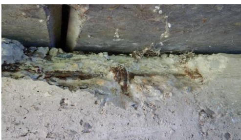
Afgedrukt beton landhoofden
